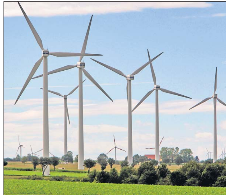
Allein in den vergangenen Monaten sind 22 Bauanträge für Windkraft beim Kreis Paderborn eingegangen. Foto: Hannemann
