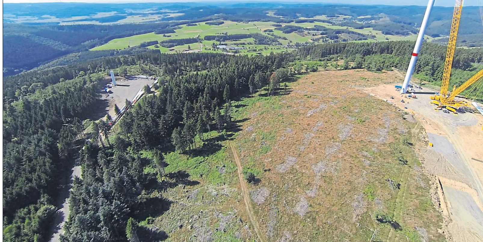
Im siegerländischen Bad Laasphe ist 2013 der bislang einzige Windpark in einem NRW-Wald eröffnet worden. Hier ein Foto von den Bauarbeiten.
