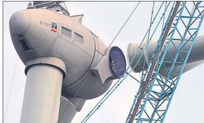
Winzig und kaum zu erkennen: In der Öffnung stehen zwei Monteure, um den Flügel zu montieren. Foto: Nobbe
