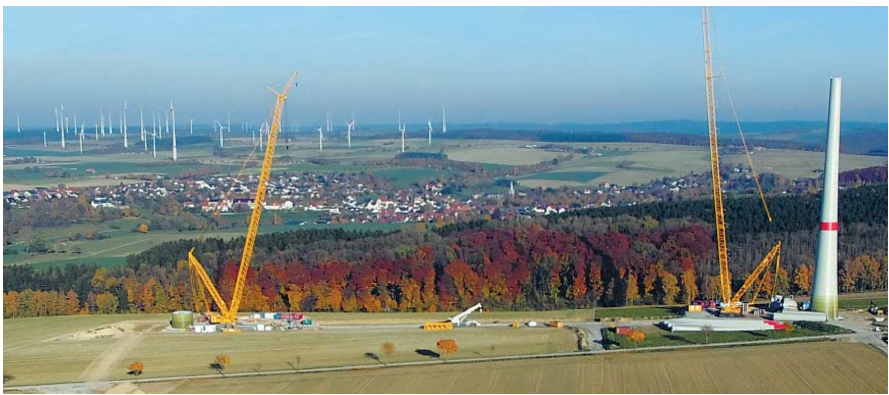
Blick auf den Ortsteil Dahl: Diese neuen Windräder entstehen gerade nahe des Iggenhauser Weges.
