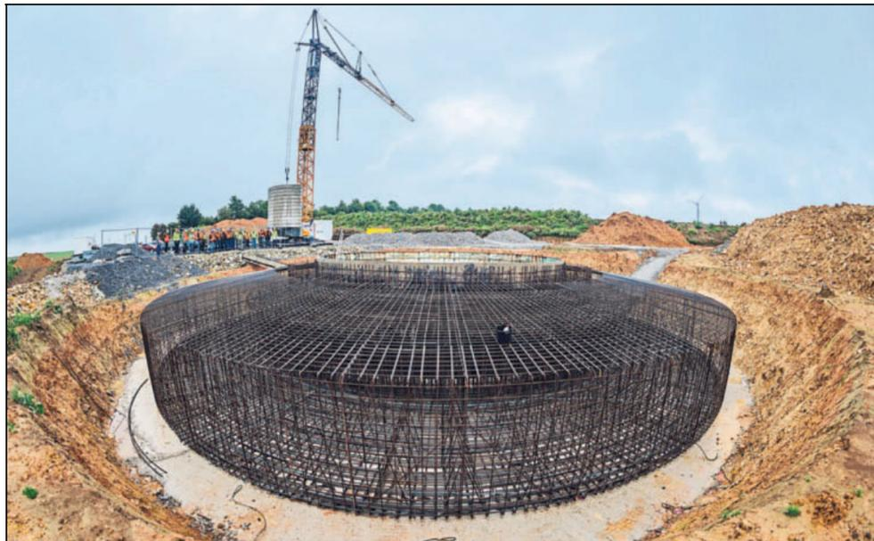
Das Fundament für eine neue Anlage E115 ist gegosedrehten Suppenschüssel. Als nächstes wird der Turm Stück für Stück aufeinander gesetzt. Es bleibt innen hohl – vergleichbar mit einer um-
