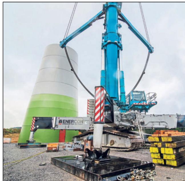
Mit tonnenschweren Baukränen werden die Betonsegmente nacheinander trocken aufeinandergesetzt.
