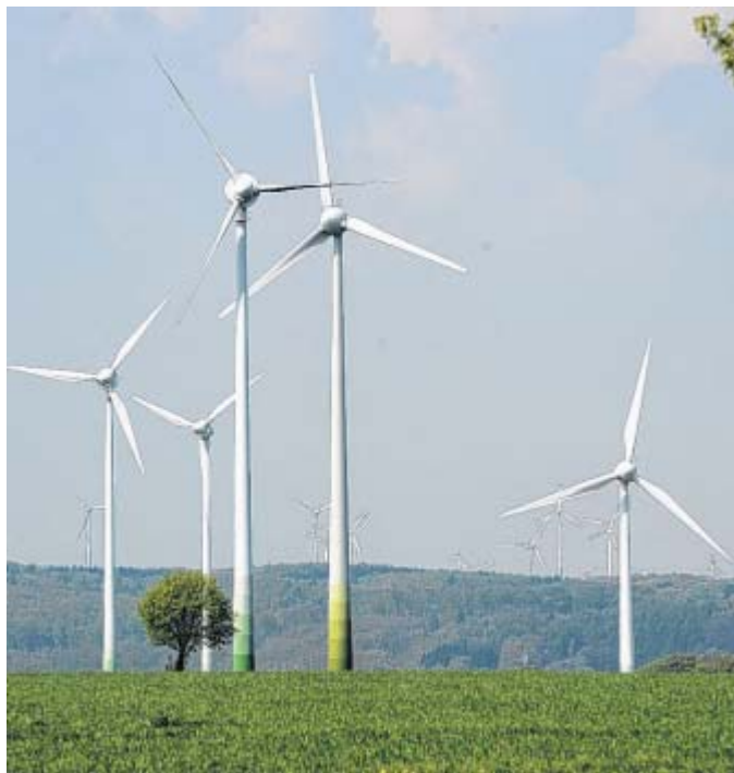
In Borchchen gilt die 100-Meter-Grenze: Investoren möchten gerne höher hinaus. Allein für Etteln gibt es 17 Bauanträge. FOTO: KÖPPELMANN
