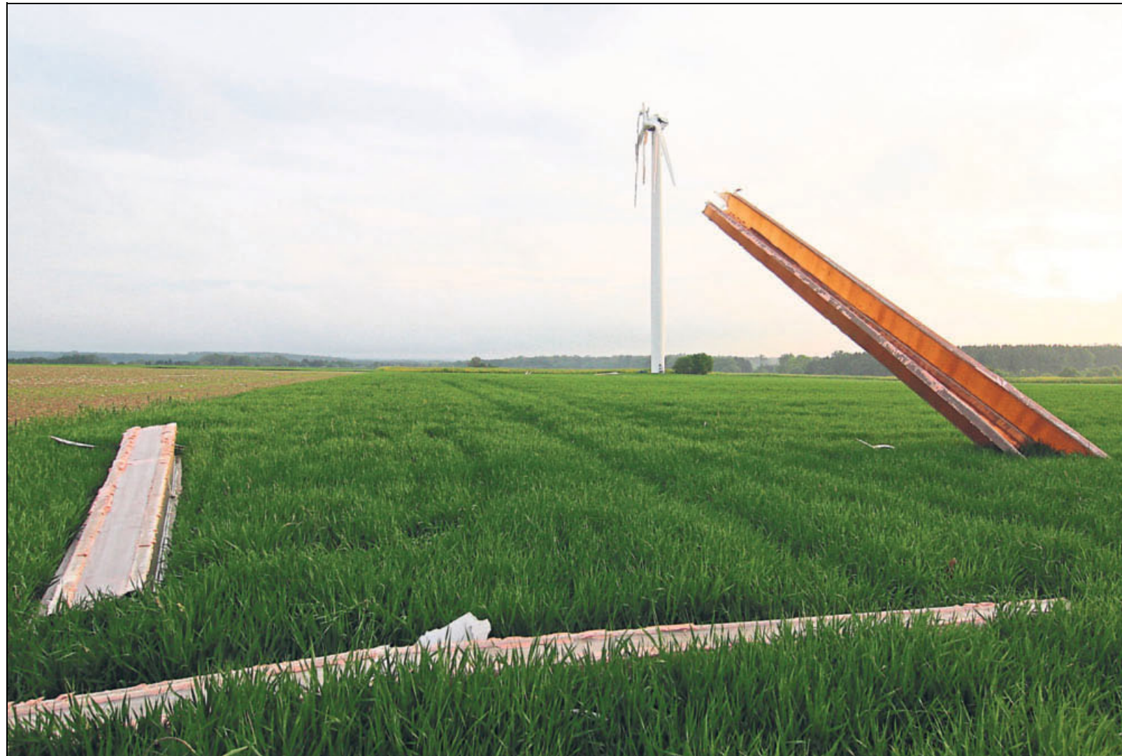
Trümmerteile der Rotorblätter schlugen weit entfernt von der Anlage im Feld auf.
