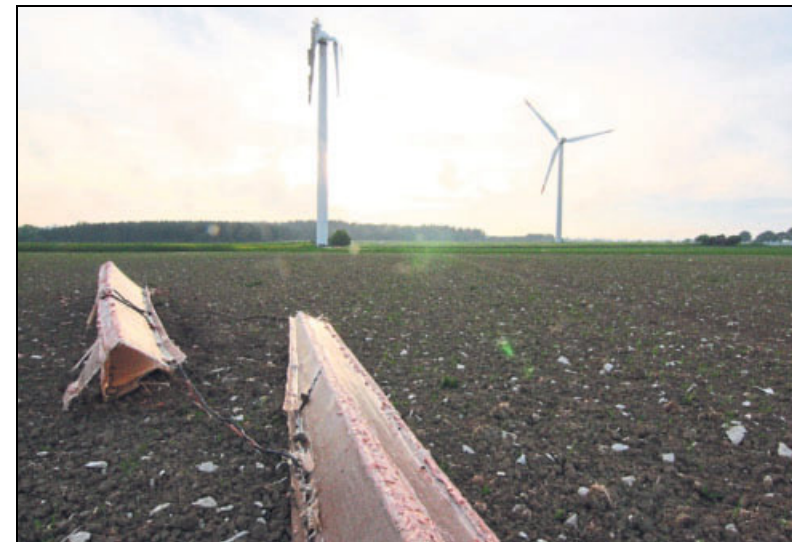
Auch auf der anderen Seite der zerstörten Windkraftanlage lagen Teile der zerfetzten Flügel auf einem Acker.
