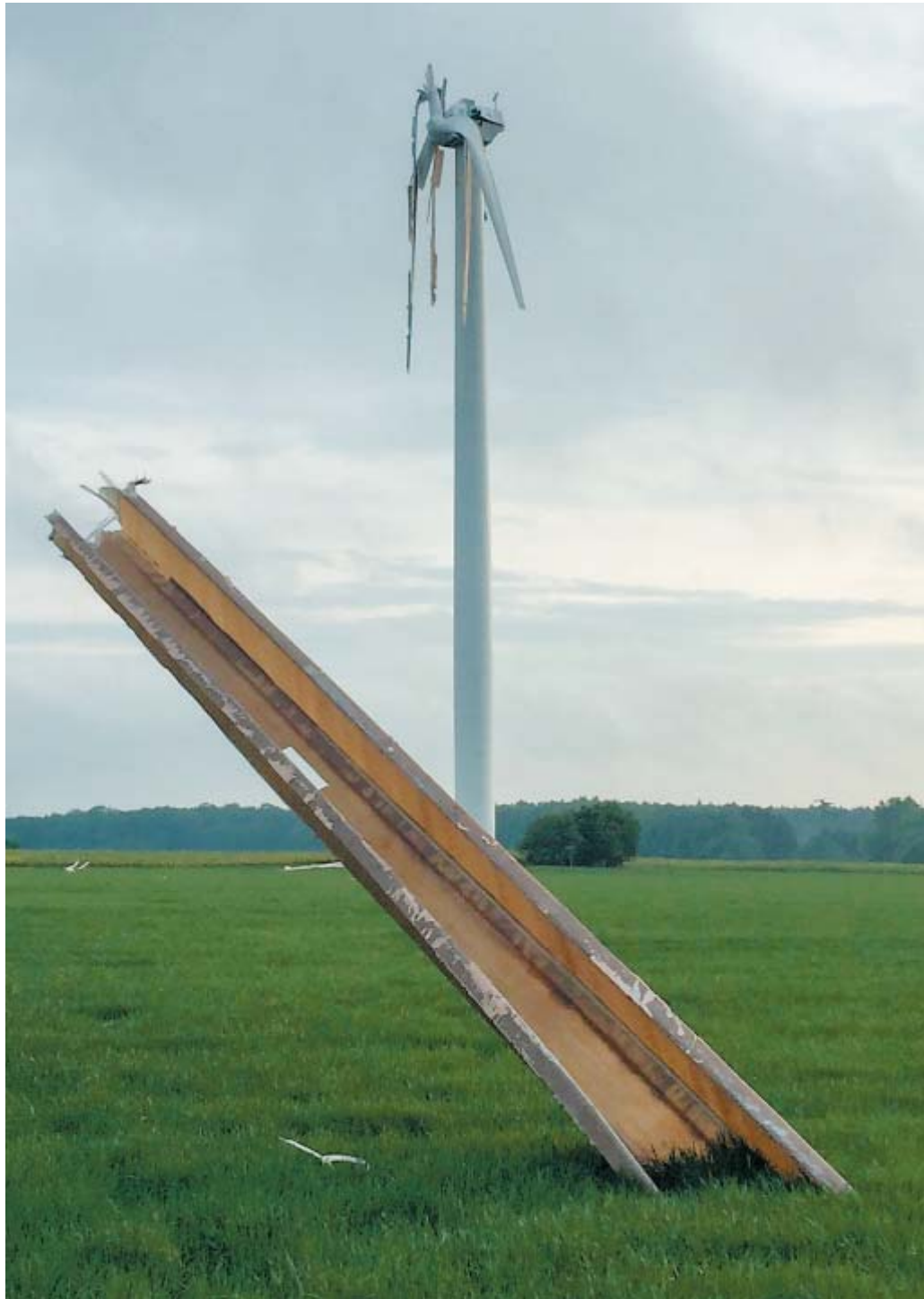
Eingeschlagen: Teile eines 1,9 Tonnen schweren Flügels stecken im Boden. Im Hintergrund der Turm der Tacke-Anlage mit den Resten des dritten Flügels und der leeren Triebwerksgondel. FOTO: MARC KÖPELMANN
