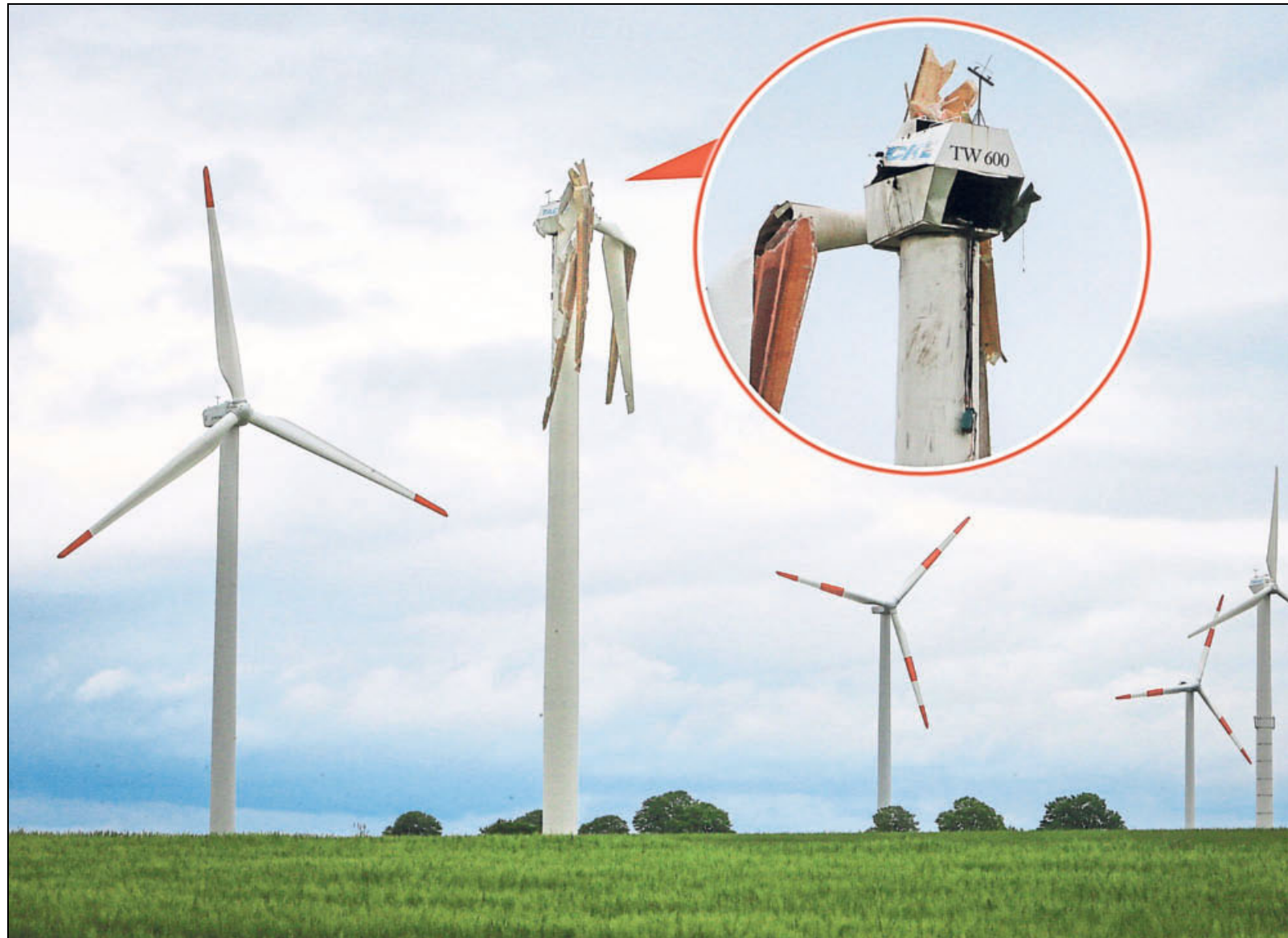
Ob ein Blitzschlag oder eine Windböe dazu führte, dass Teile der tonnenschweren Rotorblätter mehr als 100 Meter weit flogen, ist derzeit noch offen. Von allen acht Anlagen des Typs TW-600 hat der Kreis die Wartungsunterlagen eingefordert. Fotos: Jörn Hannemann
