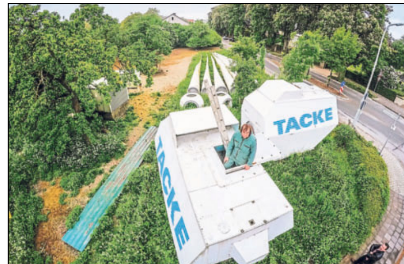
Auf seinem Grundstück lagert Franz-Josef Vogt Ersatzteile für die jetzt havarierte Windkraftanlage.
