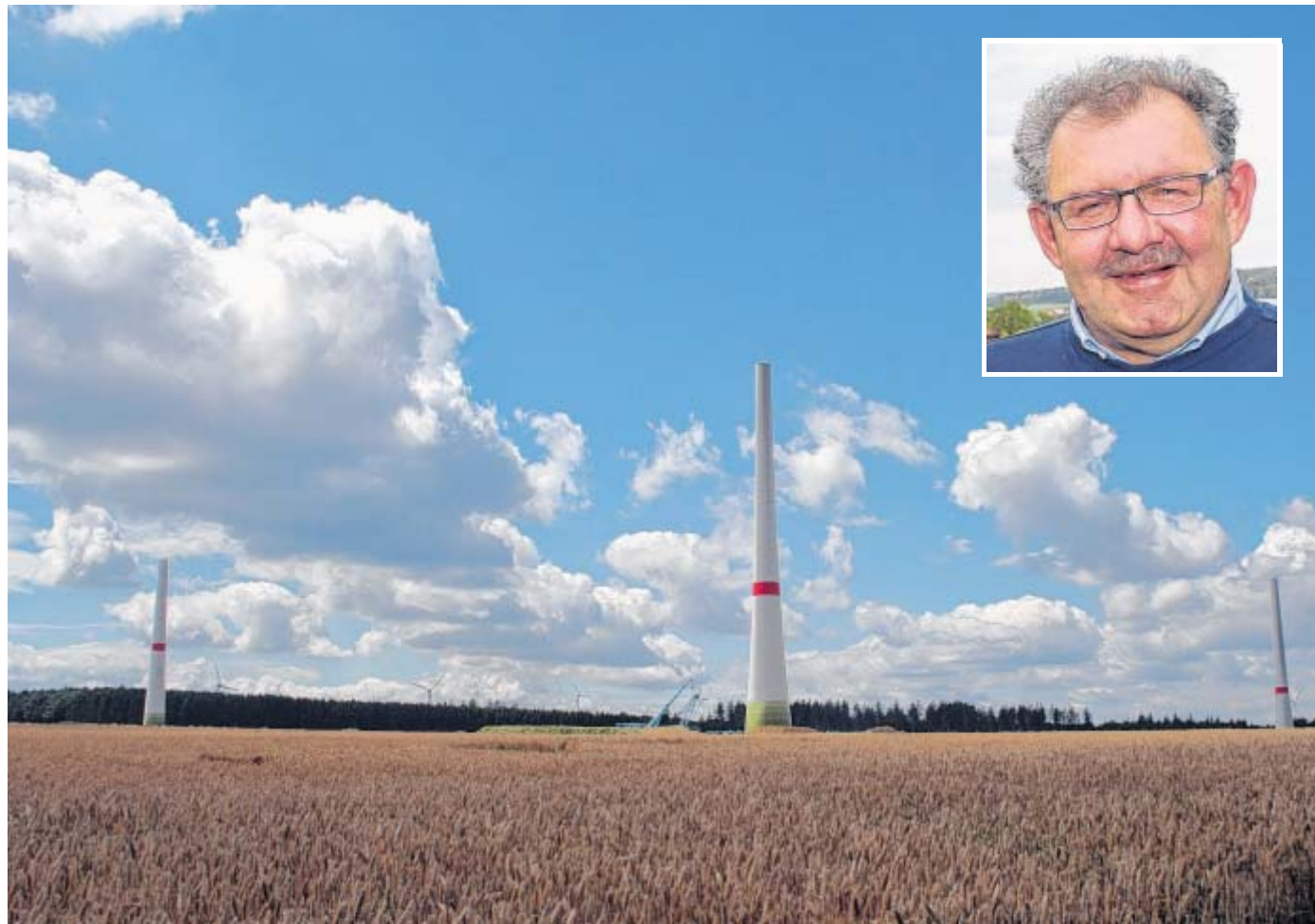
Baupause: Für diese drei Anlagen im Windpark Himmelreich im Bereich der Stadt Marsberg hat das Verwaltungsgericht Arnsberg einen vorläufigen Baustopp erlassen. Für Hubertus Nolte (kleines Bild) ein hoch interessantes Verfahren.
