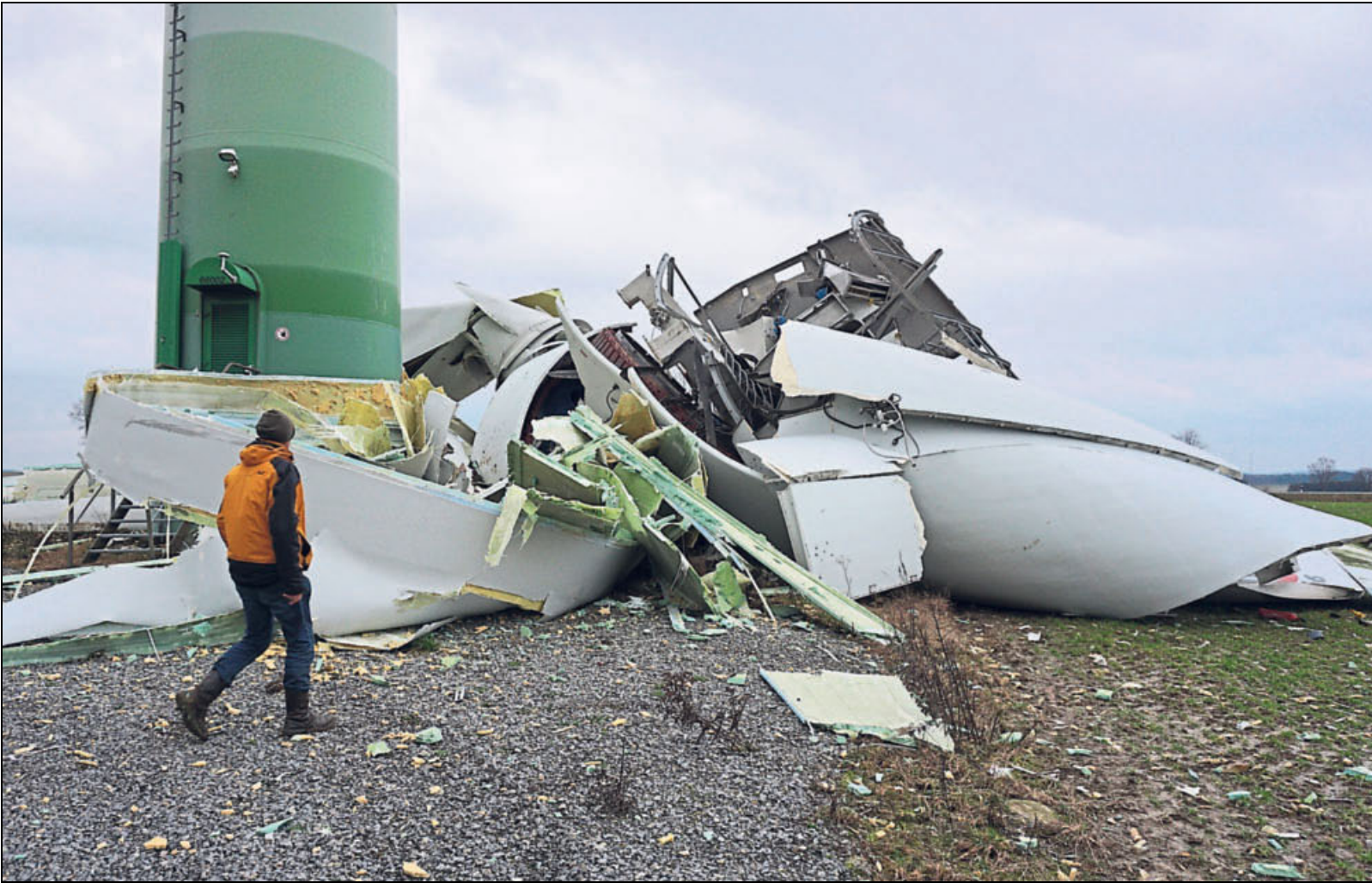
Ein Rotor samt Generator, zusammen etwa 100 Tonnen schwer, stürzte am 26. November vom 67 Meter hohen Mast in Paderborn-Neuenbeken. Nach Angaben des Herstellers Enercon hatte es einen solchen Vorfall zuvor noch nie gegeben. Verletzt wurde niemand. Foto: Saage
