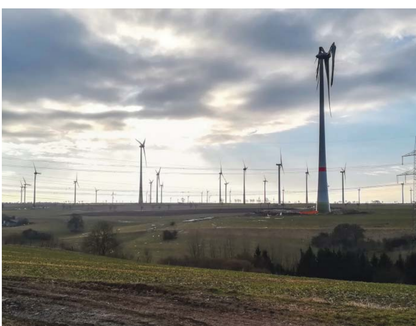
Düsteres Panorama: Dieses Bild zeigt das ganze Ausmaß der Havarie. Zwei der drei Rotorblätter des brandneuen Windrads vom Typ E-115 hängen in 149 Meter Höhe völlig zerfetzt herab. Links von der Anlage sind weiße Kunststoff-Trümmer zu sehen. FOTOS: GEMEINDE BORCHEN
