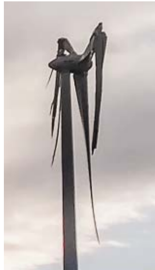
Ganz geknickt: Das Windrad lässt die zerstörten Flügel hängen.
