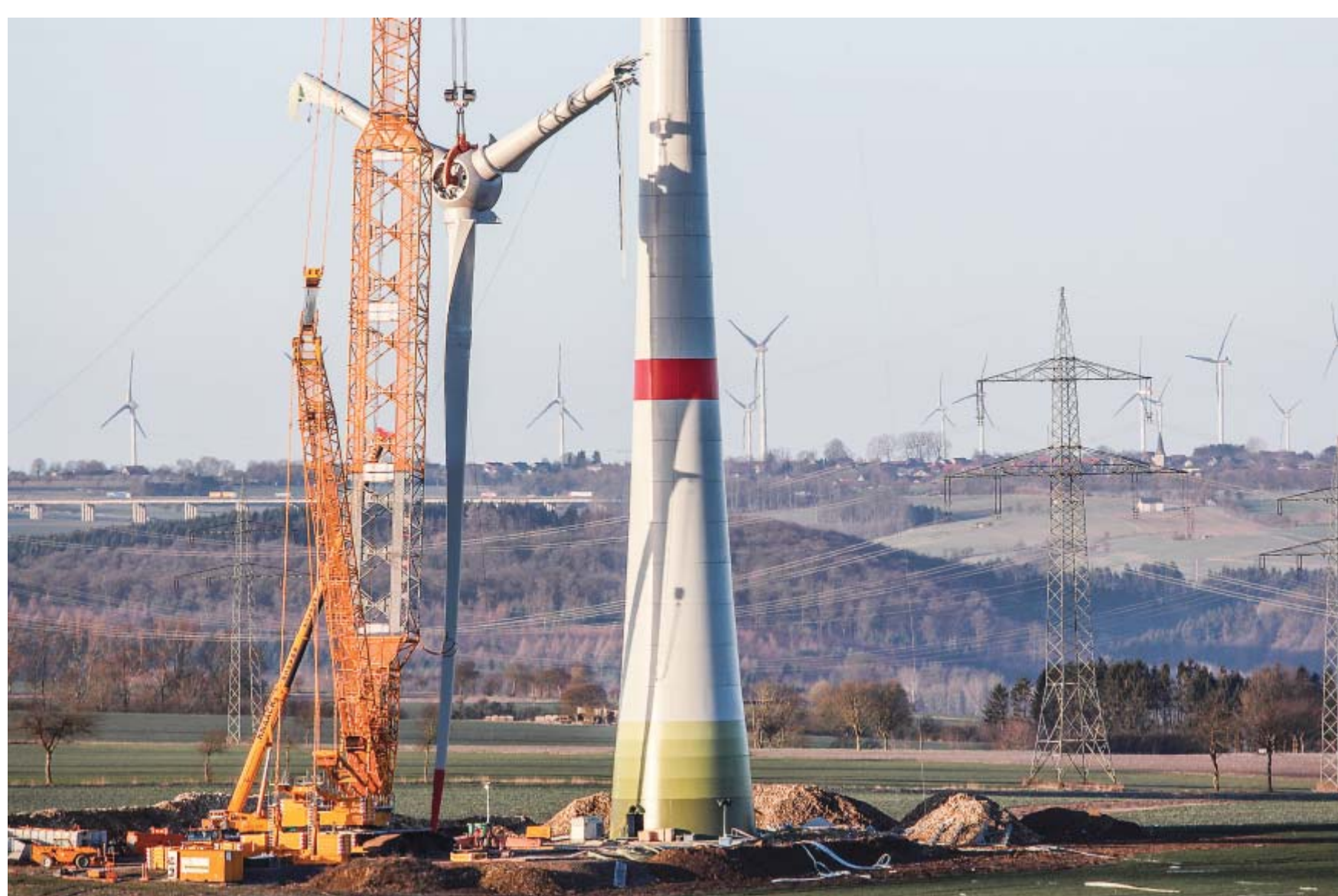
Abbau nach der Havarie: Anfang April konnten die beschädigten Rotorblätter und die Gondel des Windrades demontiert werden. Eine effektive Reinigung der umliegenden Felder sei erst danach möglich gewesen, heißt es von Westfalenwind. Zuvor seien immer noch Glasfaserteile von Flügeln zu Boden gefallen. FOTO: JENS REDDEKER
