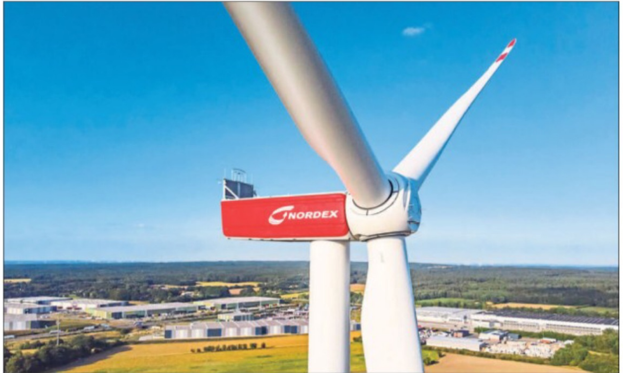
Nordex größtes Windrad, die N 149 mit einer Gesamthöhe von 238 Metern, ist jetzt südlich von Hamburg errichtet worden. Fünf baugleiche Anlagen sind jetzt für Borchen in einem kleinen Park beim Gewerbegebiet Kirchborchen beantragt worden. Foto: Nordex
