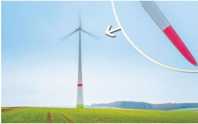
Mit den Kämmen an den Flügeln dreht sich auch dieses Windrad bei Schwaney leiser. Insbesondere der Geräuscheffekt beim Vorbeidrehen am Mast wird dadurch verhindert. Etwa zehn Anlagen im Kreis sind mit dem Patent bereits ausgerüstet. Fotomonage: Jörn Hannemann
